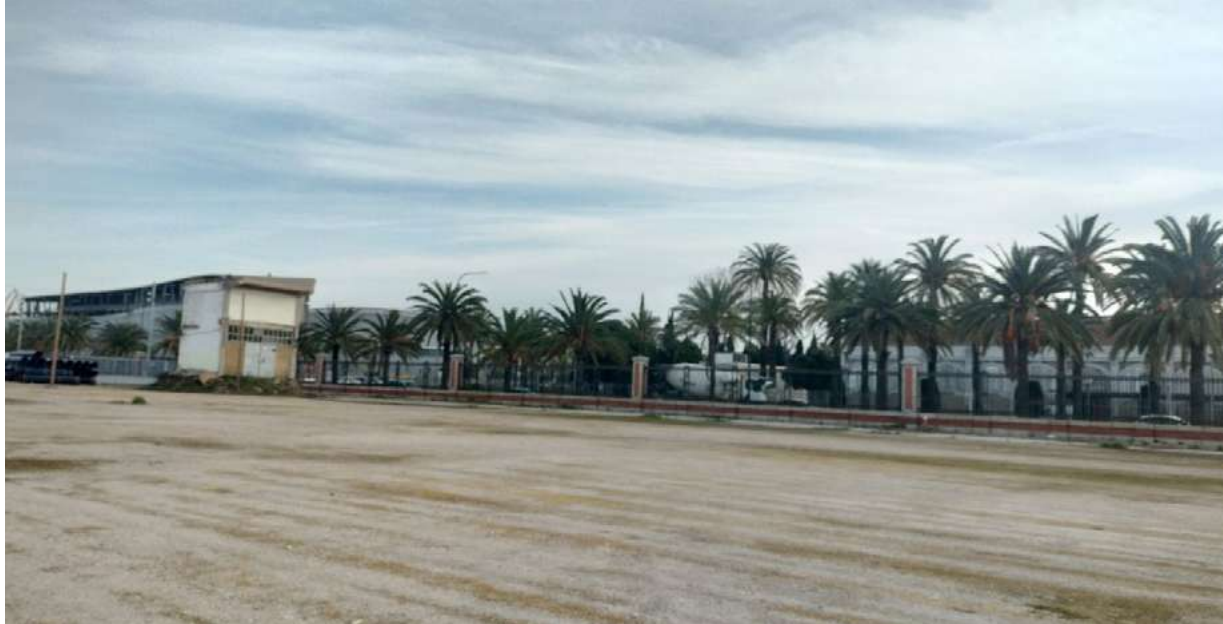
Demolición del último módulo (durante las obras).
