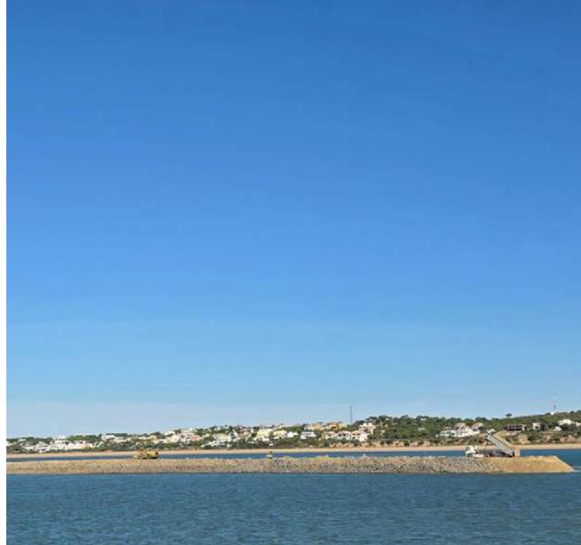
Recinto nº4 Fase 2 (durante las obras)
