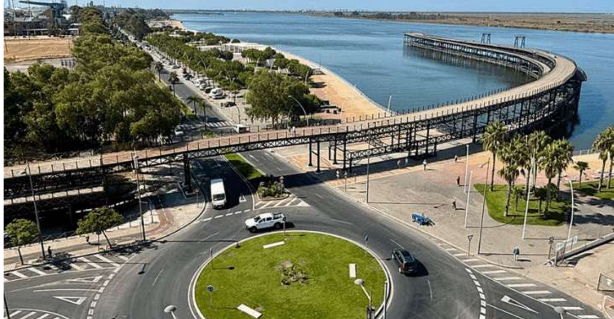
Unión Muelle Riotinto (finalización de las obras).
