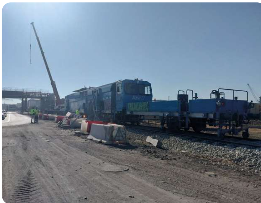
Rehabilitación vía 2S2 (durante las obras).
