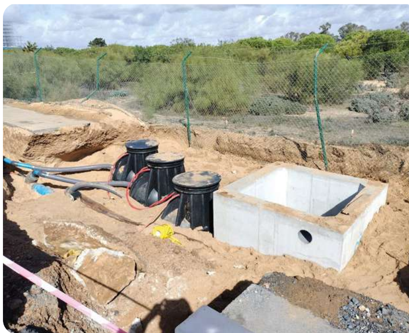
Conexión saneamiento Muelle Sur (durante las obras).
