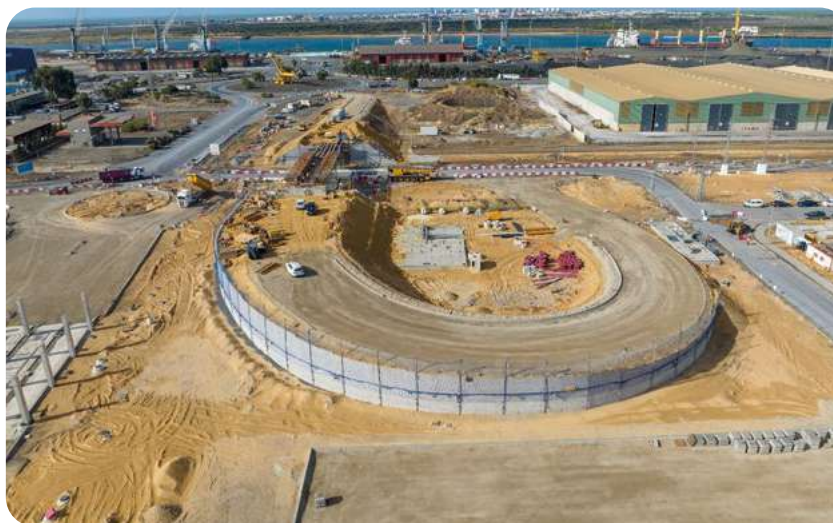
Nuevo acceso único (durante las obras).
