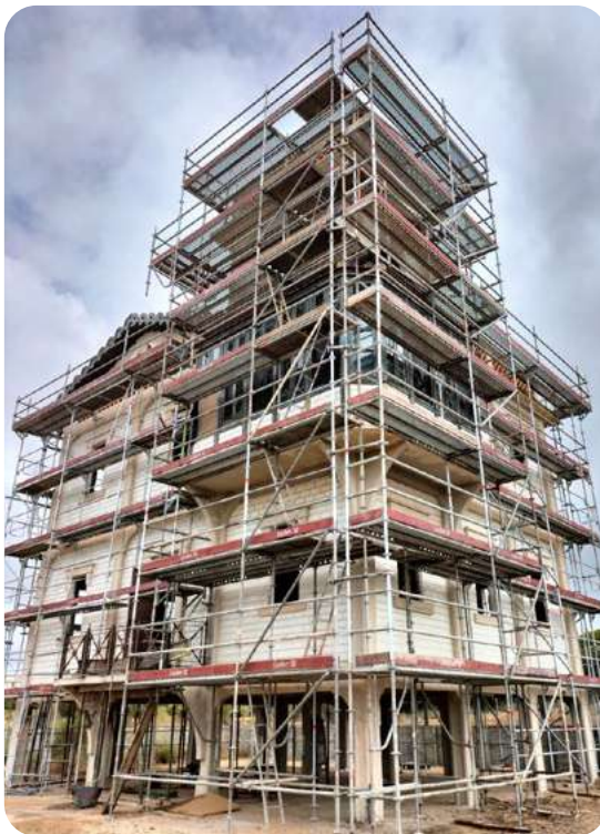
Rehabilitación Casa del Vigía (durante las obras).
