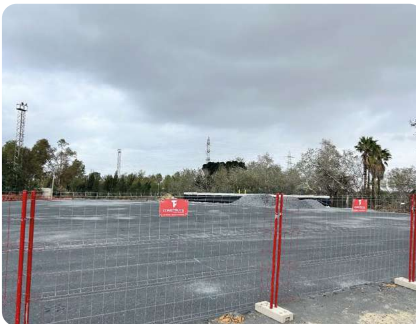
Ampliación del aparcamiento de la Punta del Sebo (durante las obras).
