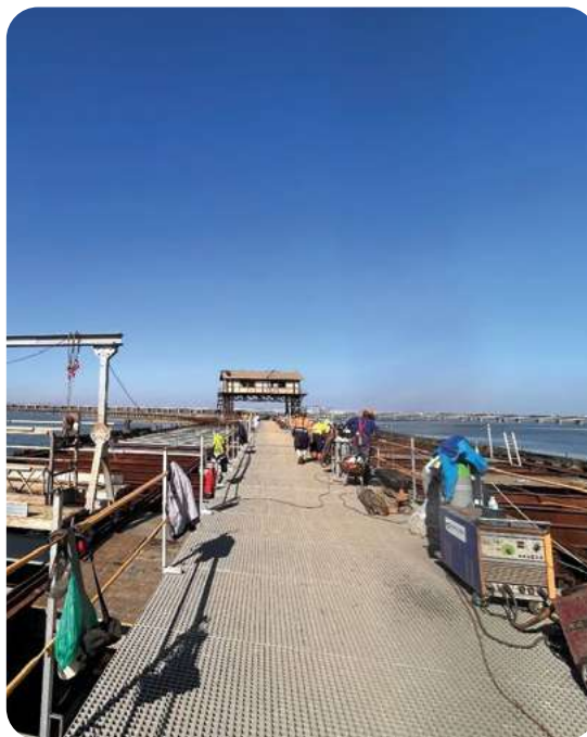
Rehabilitación del Muelle de Tharsis (durante las obras).
