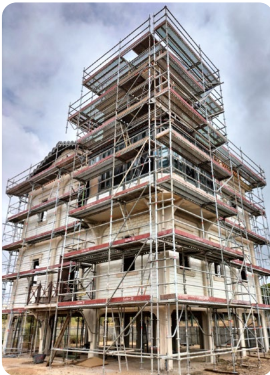
Rehabilitación Casa del Vigía (durante las obras).
