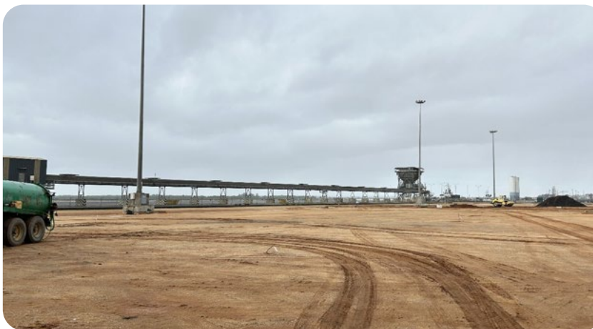
Ampliación pavimento Muelle de Minerales (durante las obras).
