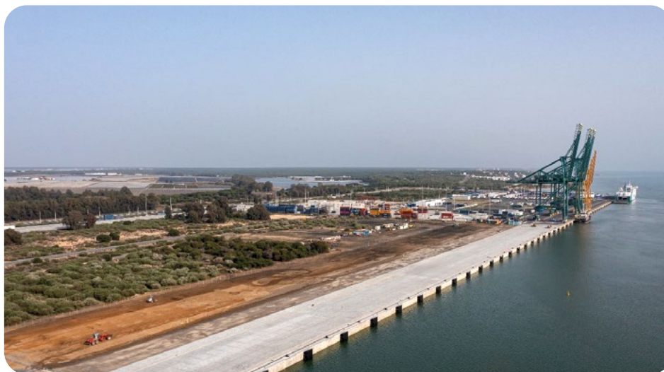
Ampliación Norte del Muelle Sur (tras la finalización de las obras).
