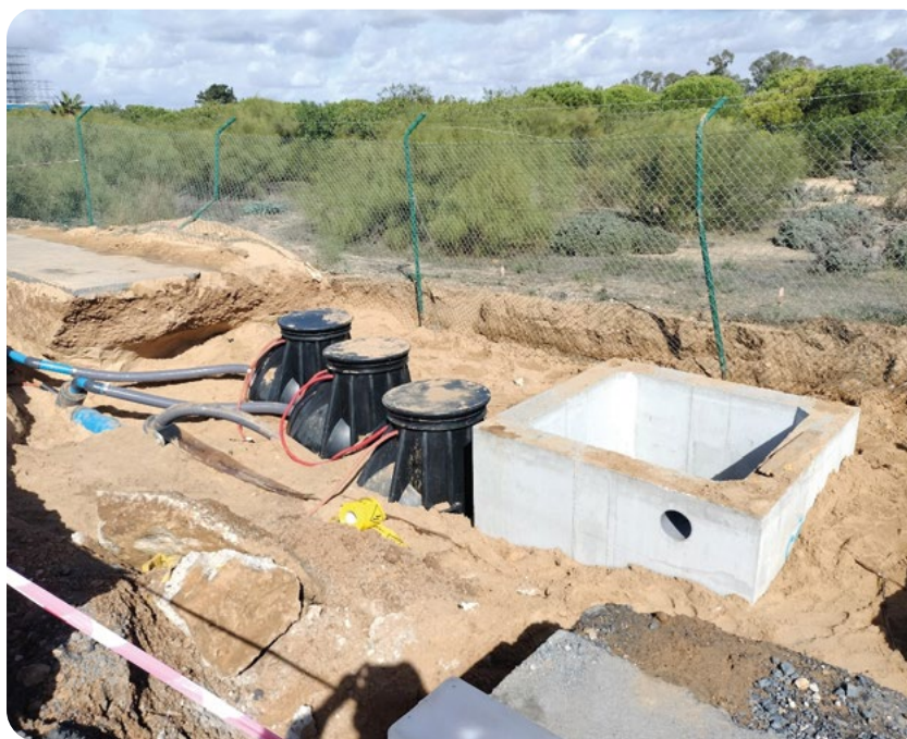
Conexión saneamiento Muelle Sur (durante las obras).
