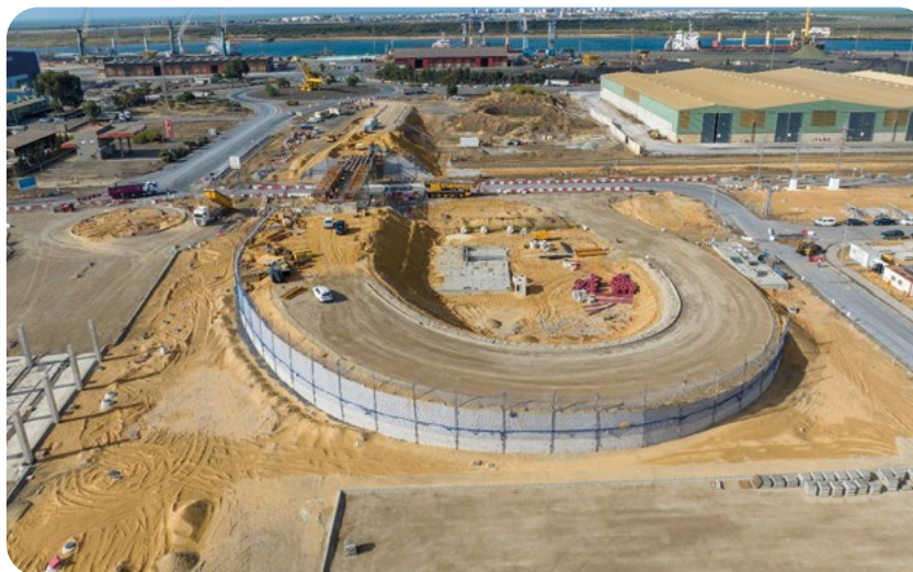
Nuevo acceso único (durante las obras).
